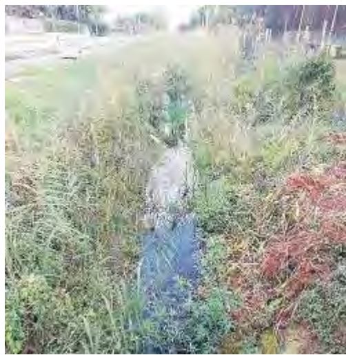
Il canale di bonifica al rione Santa Pelagina foto Genovese
