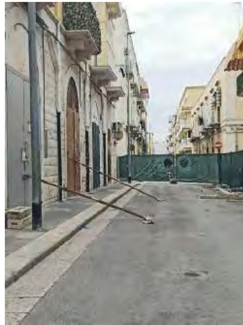
VIA D'AZEGLIO Le case pericolanti sono state solo puntellate
